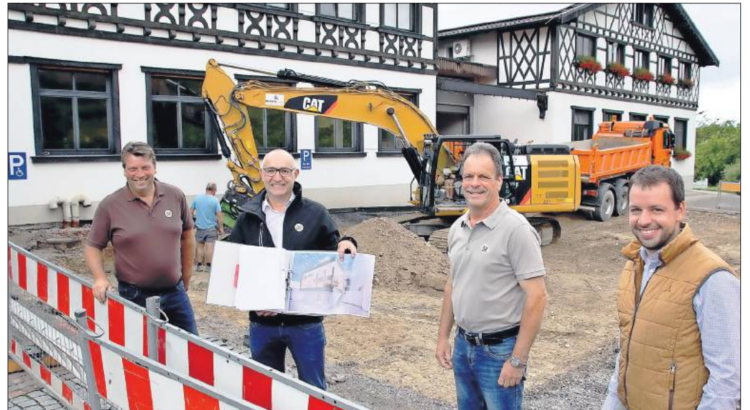
Das 3,9 Millionen Euro-Projekt des „Alde Gott“ hat mit dem ersten Baggerbiss begonnen. Im Herbst 2022 soll die neue Genusswelt fertig sein. Von links: Vorstandsvorsitzender Hubert Vierthaler, Geschäftsführer Günter Lehmann, Vorsitzender des Aufsichtsrates Hans-Peter Huber sowie Bauleiter Adrian Schaufler
