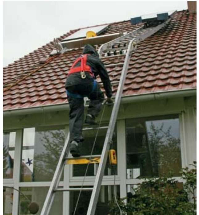
Mit einem Spezial-Lift, den Matthias Irrgang auf der Intersolar gekauft hat, werden die Kollektoren aufs Dach befördert – sogar bei Regen. Der zunächst hohe Anschaffungspreis habe sich laut Irrgang innerhalb kürzester Zeit amortisiert
